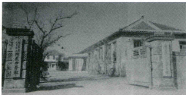
下伊敷町にあった校舎(昭和26年)
