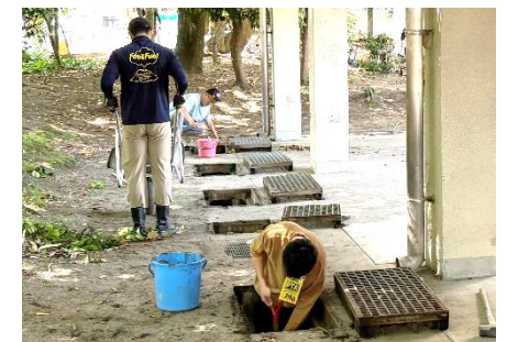
【渡り廊下横の側溝を清掃する保護者の姿】
